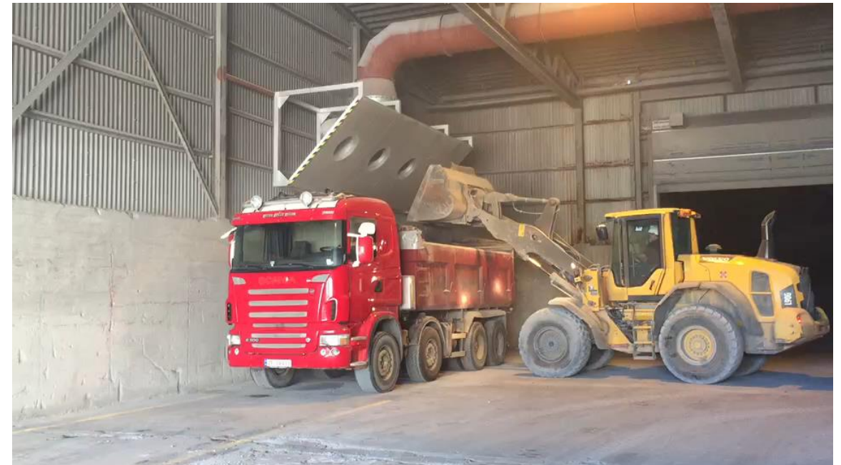
Effiziente Stauberfassung mittels Düsenkanal
