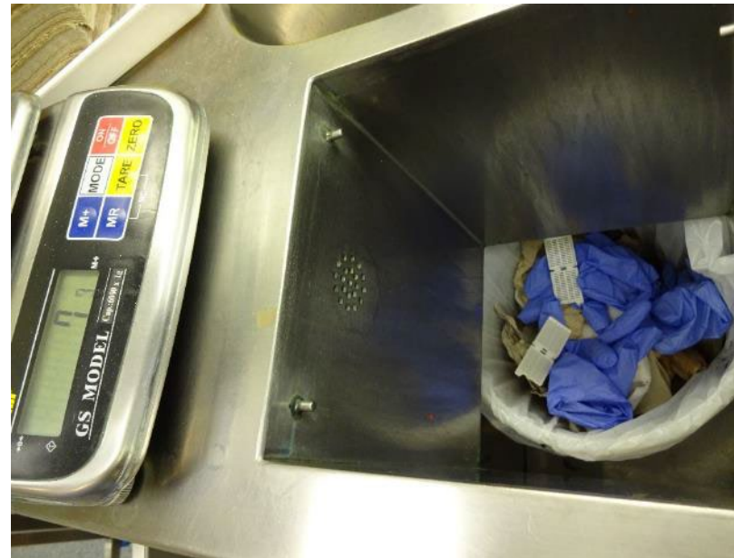
Abgesaugter Müllabwurf am Arbeitsplatz kleiner Zuschnitt
